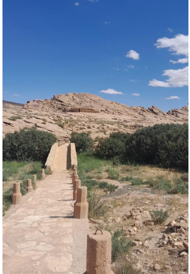
Figure 05 : L'allée piétonne d'accès au site.
