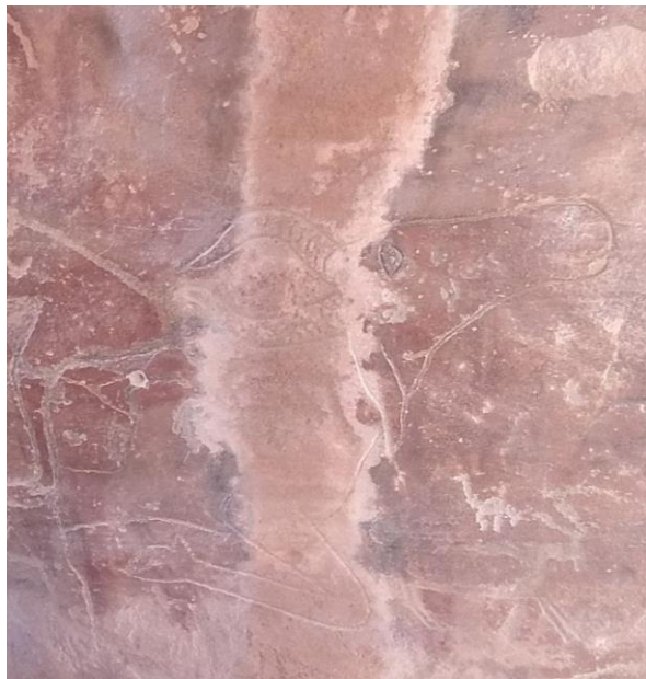
Annexe n°12 : Altération de la pierre.
