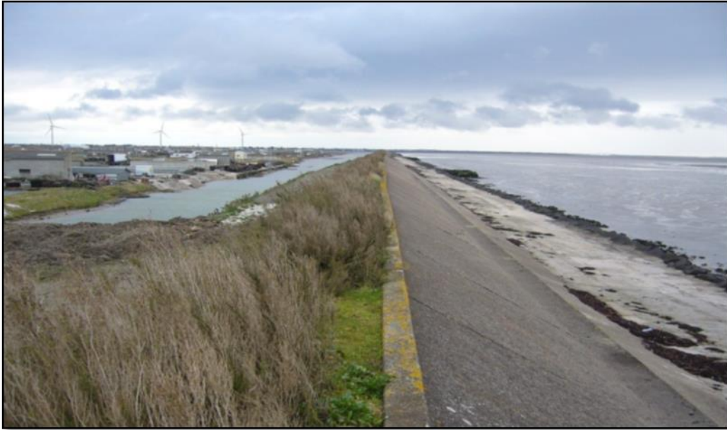
Figure V. 2 : Digue frontale (l'exemple de Beauvoir-sur-Mer, en France) d'après CETMEF (2011)
