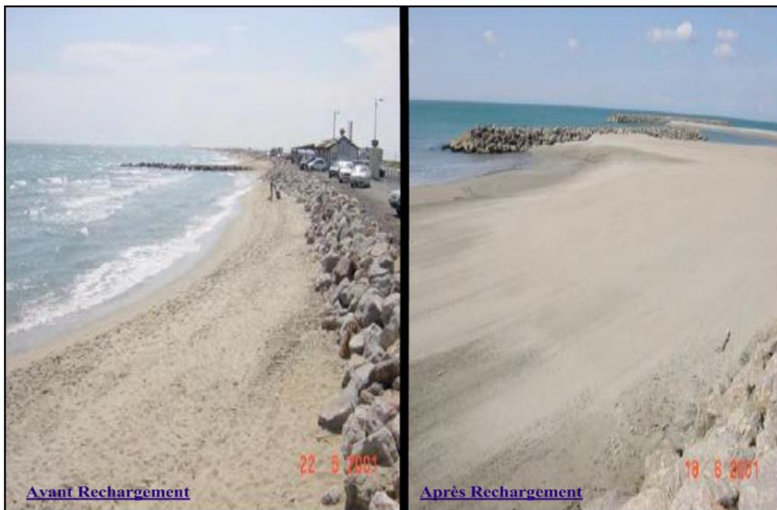
Figure V. 6 : Récupération des plages par la technique du rechargement artificiel (in vivo environnement, 2005)
