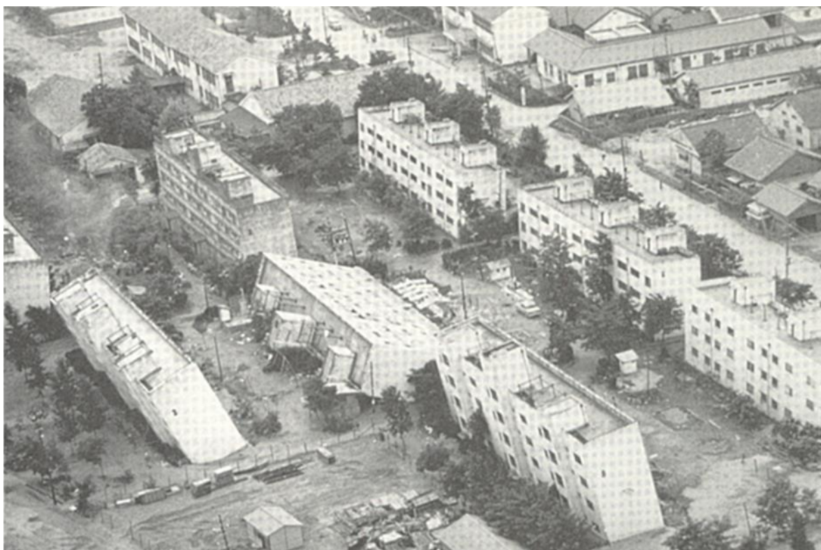
Figure 1.11 : Représentation du phénomène de liquéfaction des sols.
