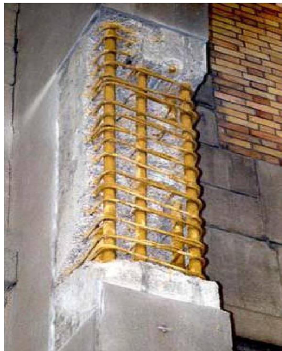
Figure I.1 : Réfection des bétons et protection des armatures.
