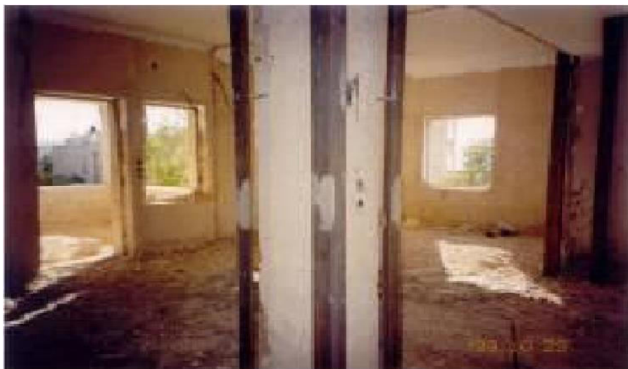
Figure I. 6 : Renforcement de poteaux au moyen de profilés métallique.
