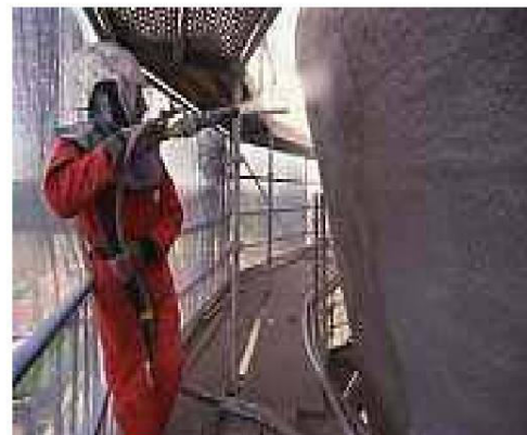
Figure I.2 : Renforcement au moyen de béton projeté
