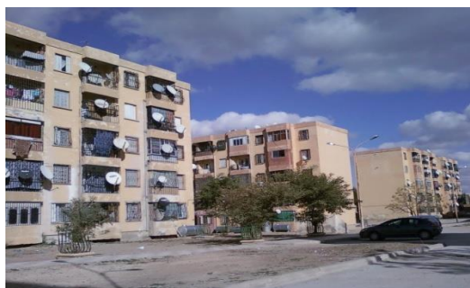
Photo N° 10: L'habitat dans La cité Haoues
