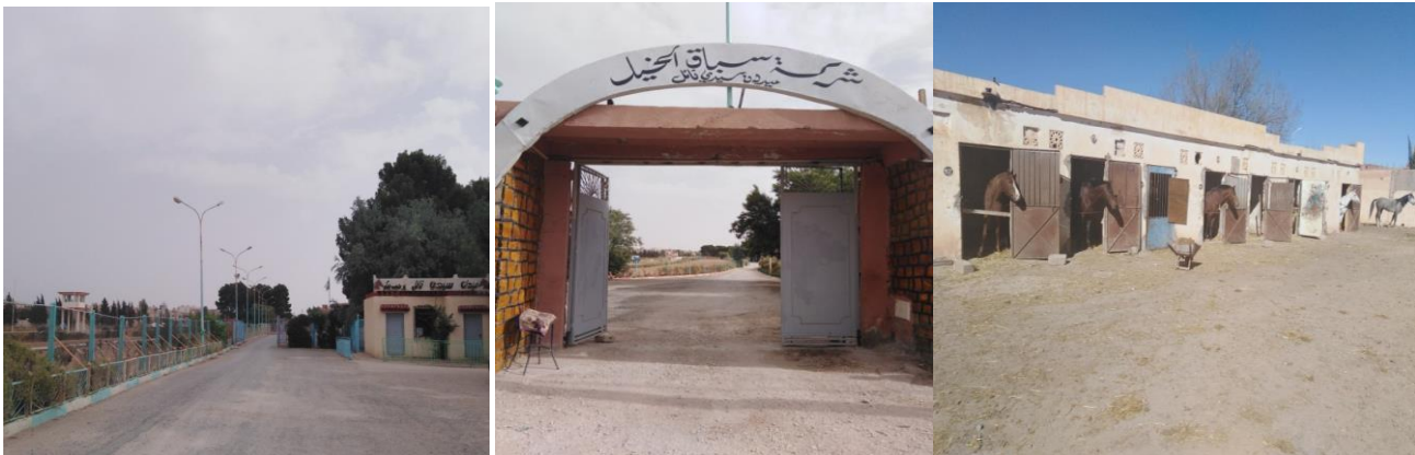
Fig.10 – Vue générale de la station de l'Hippodrome située à Djelfa (Originale)
