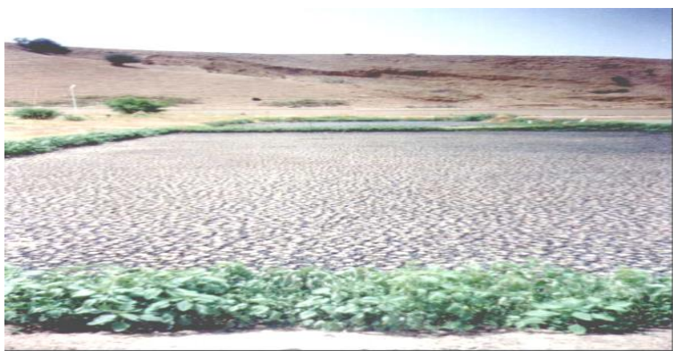
Fig. III.10 : Lits de séchage des boues
