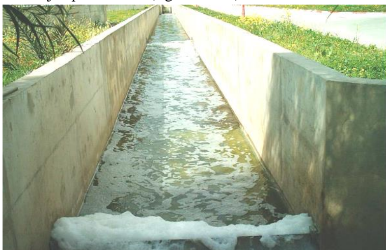
Fig. III.9 : Canal des rejets de la station d'épuration
