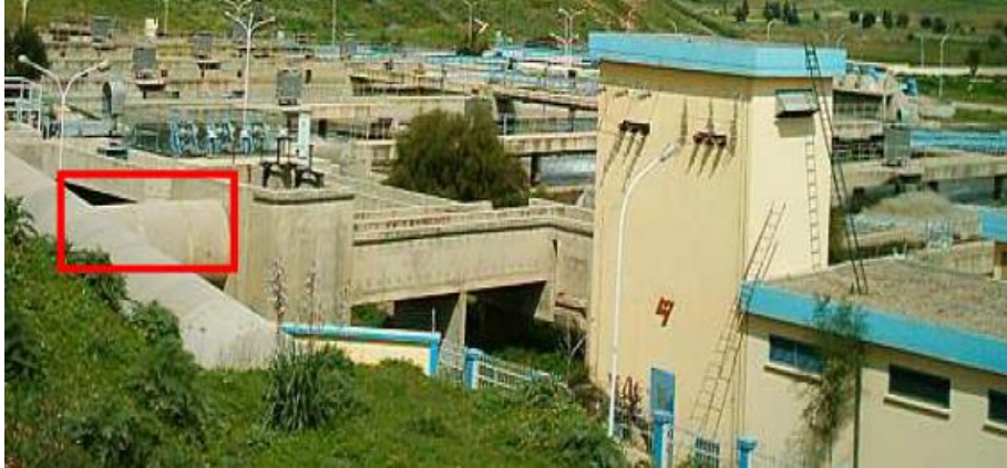
Fig. III.4. Conduite principale des eaux usées qui alimente La station d'épuration qui rassemble trois exutoires.
