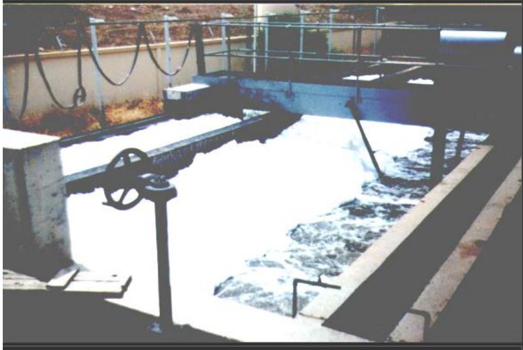
Fig. III.6 : Dessablages / Dégraissage
