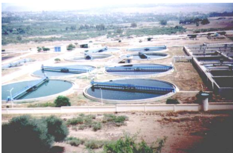
Fig. III.8 : Bassins de décantation secondaire
