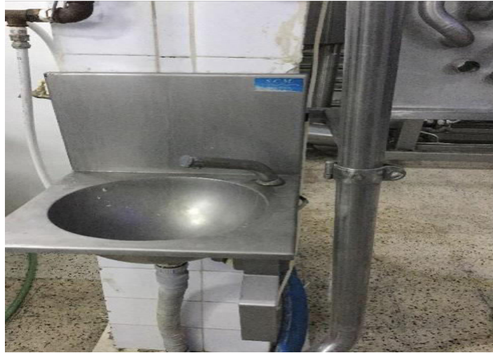
Figure 4 : Lave-mains avec une robinerie à commande non manuelle (Photo personnelle)
