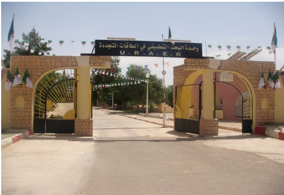
Figure (3- 6): Unité de recherche appliquée en énergies renouvelables (URAER) Ghardaïa.
