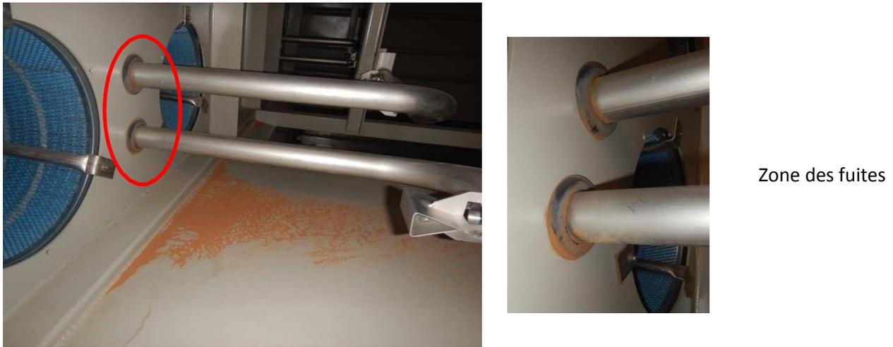
**Figure II.12 : Vue du sable et des fuites à l'intérieur du système d'admission d'air**
