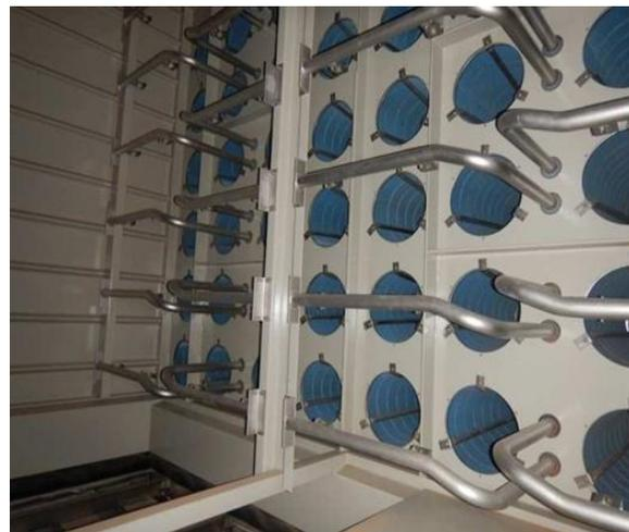
Figures II.5 : Système d'admission d'air (Batterie de filtres)
