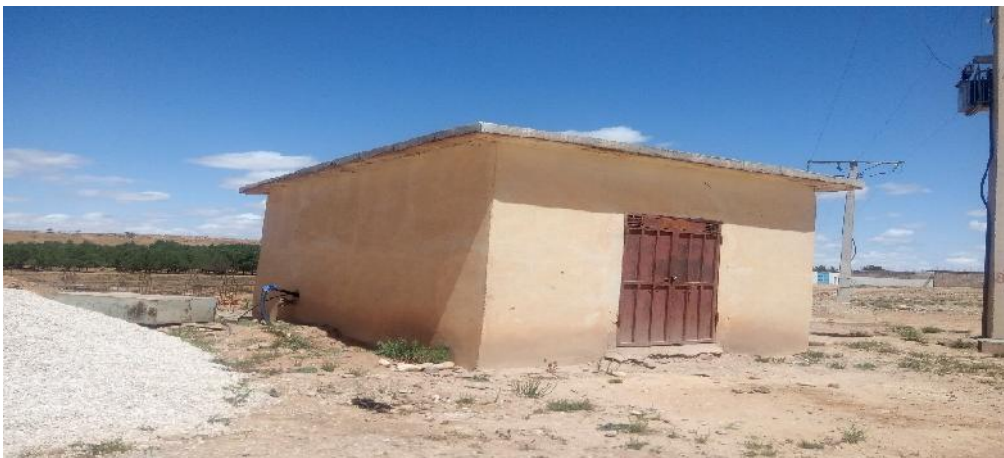
Figure 17 : Fac de Forage F1 bis
