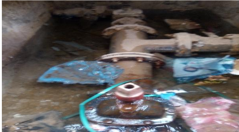
Figure 36 : Nœud à l'intérieur 2ème Chambre principale
