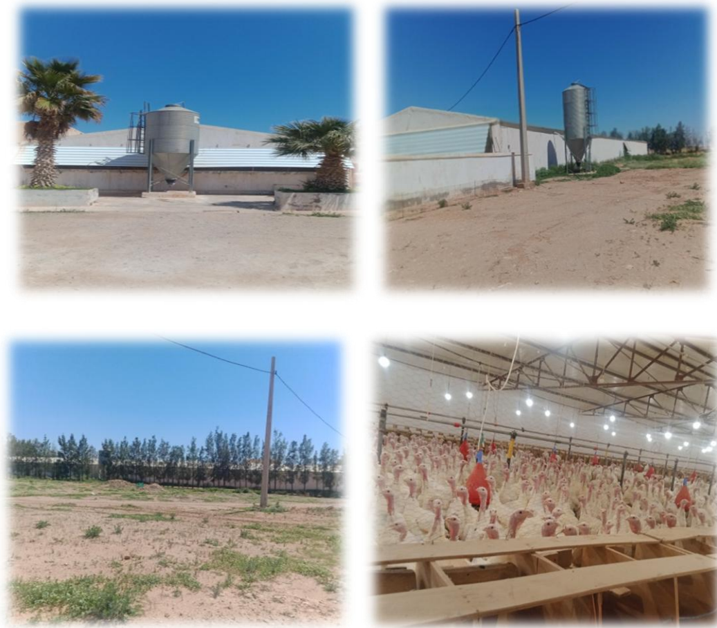
Fig. 22- Vue générale de la station d'Ain Oussera (Originale,2022)
