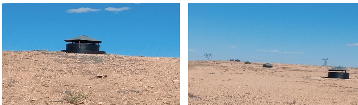
صورة رقم 22: تقنيات فوق الارض لتنفس النفايات الموجودة داخل المركز
