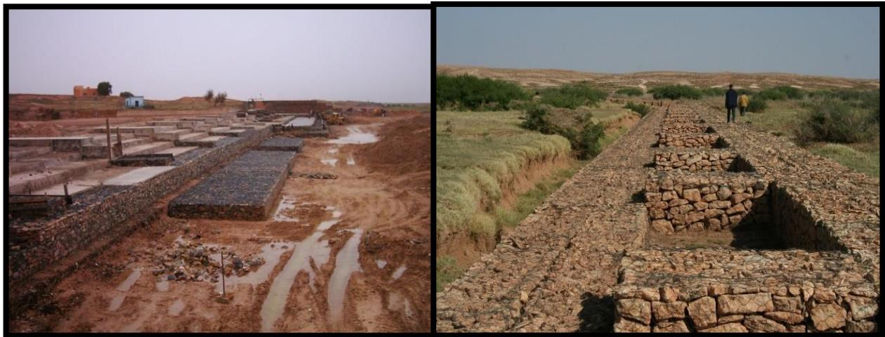
**Photo 5** : Ouvrages en gabions : C'est des ouvrages réalisés à base de gabions pour la mobilisation et la récupération des eaux de surface.
