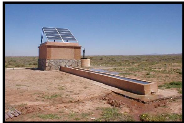
**Photo 4 :** Réalisation d'un forage équipé par l'énergie renouvelable (W. de Djelfa)
