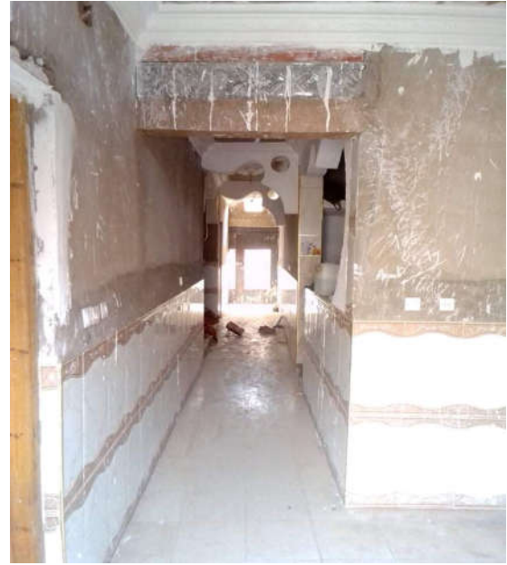
الصورة 42: رواق مسكن حديث ببغداد
