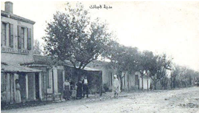
الصورة 13: مدينة (تاجنبت)
