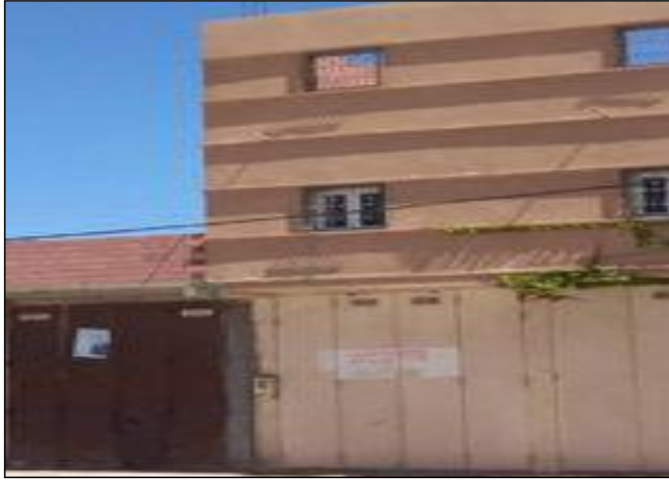
الصورة رقم (3-5): البناء بدون رخصة (حي بن سعيد)
