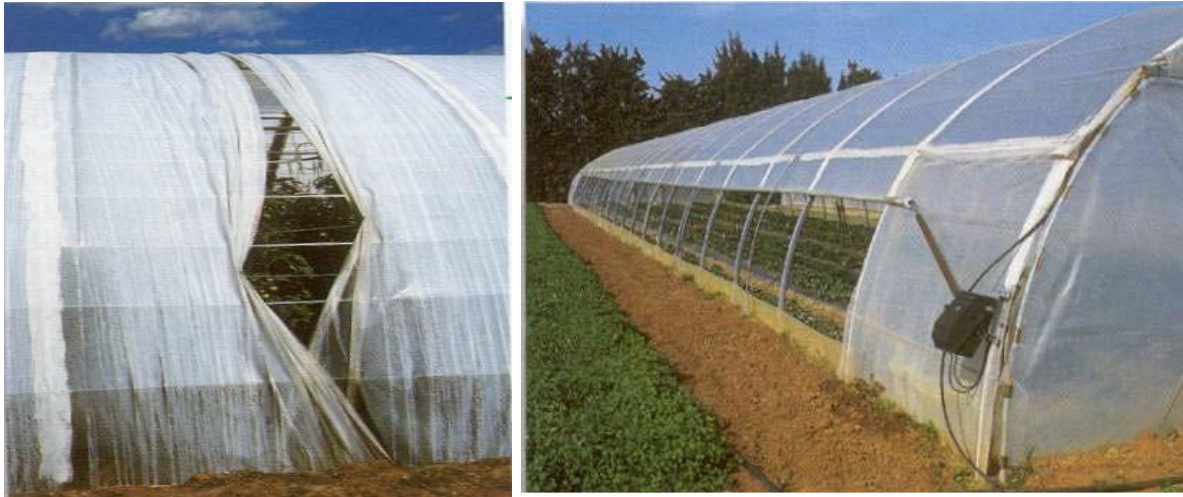
Tunnels mécaniques favorable
