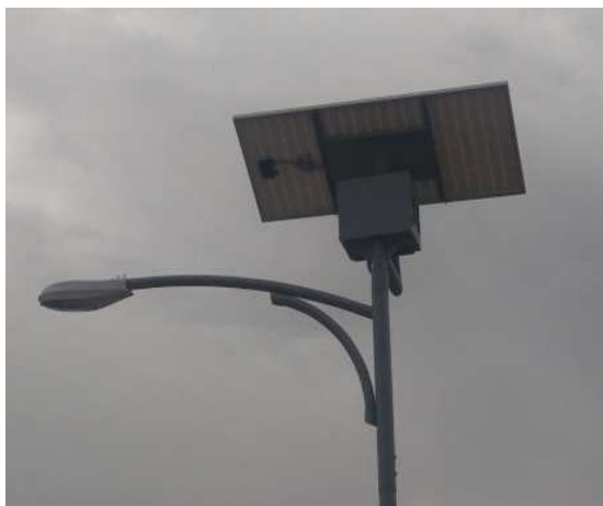
Candelabre solaire réalisé par L'UDES/CDER Source : ( https://www.cder.dz/ )
