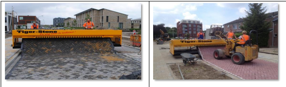
الصورة (29): آلات ومعدات متطورة لتبليط الرصيف (Tigerstone machinaal, 2022)
