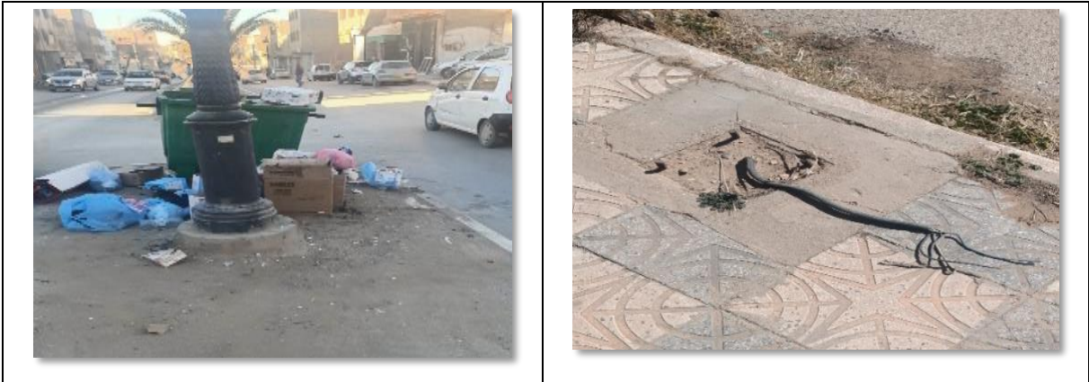
الصورة(18): إهمال أعمدة الإنارة وغياب الصيانة (إلتقاط الطالب، مارس 2022)
