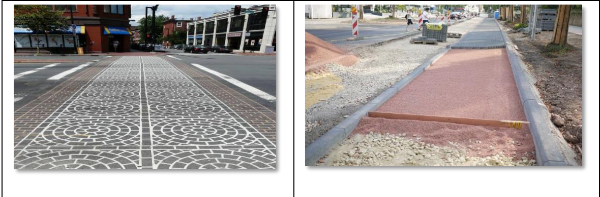
الصورة (31): استعمال خرسانة مقاومة للعوامل الطبيعية في تشييد الأرصفة (Cosm thrap, 2022)
