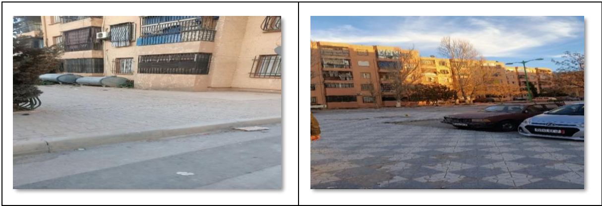
الصورة (12): رصيف نمط السكن الجماعي بحي قناني (إلتقاط الطالب , فيفري 2022)
