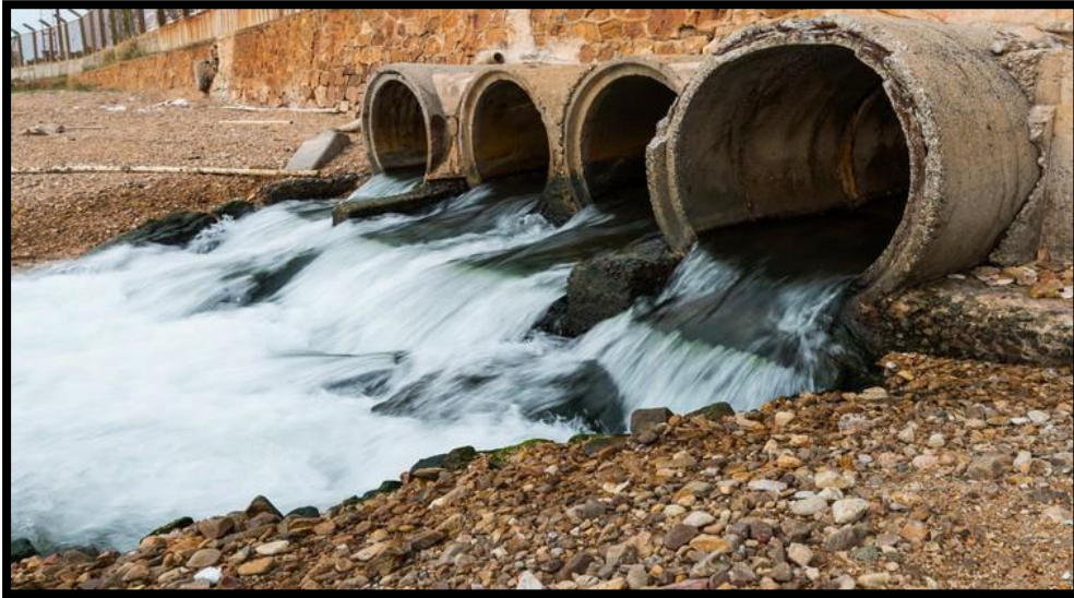
Figure n°31 : Un exemple d'un rejet des eaux usées dans un milieu récepteur.
