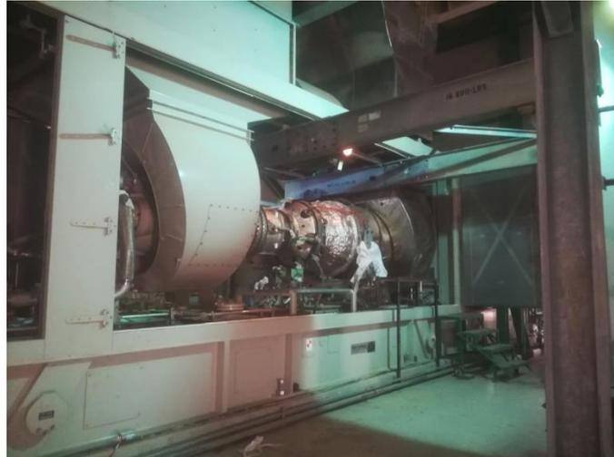
Figure (I-3) : Turbine TITAN 130 sur le site de la station de compression SC3
