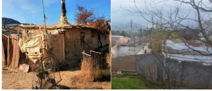
الصور رقم 14: البنائيات الهشة في حي سطارة -المدية- (سنة 2023)
