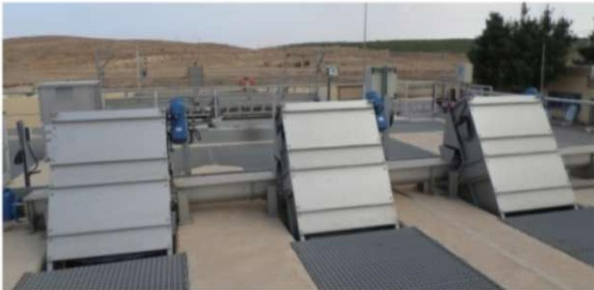
**Figure III.4** : Dégrillage fin automatique
