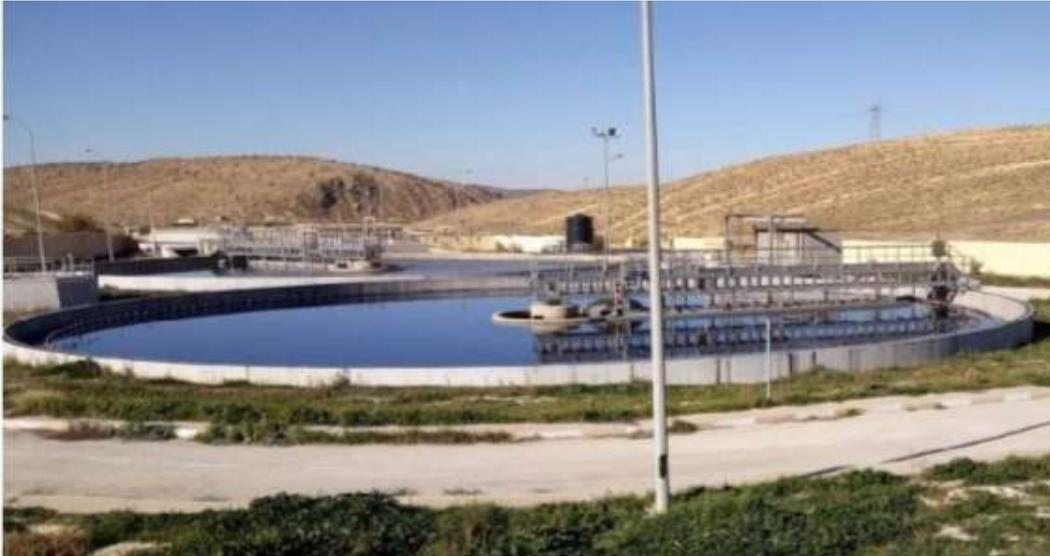
**Figure III.14 :** Décanteur secondaire (nouvelle file)
