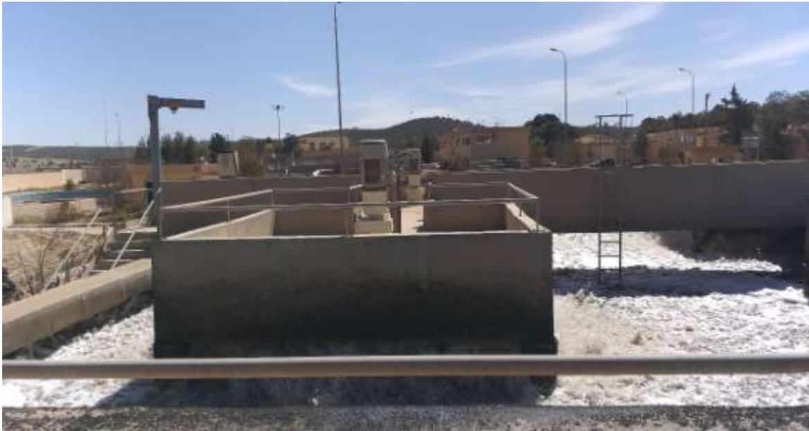
**Figure III.13 :** Bassin d'aération (nouvelle file)
