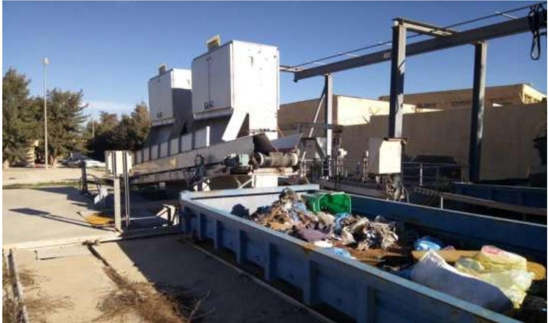
**Figure III.3 :** Dégrilleur grossier automatique
