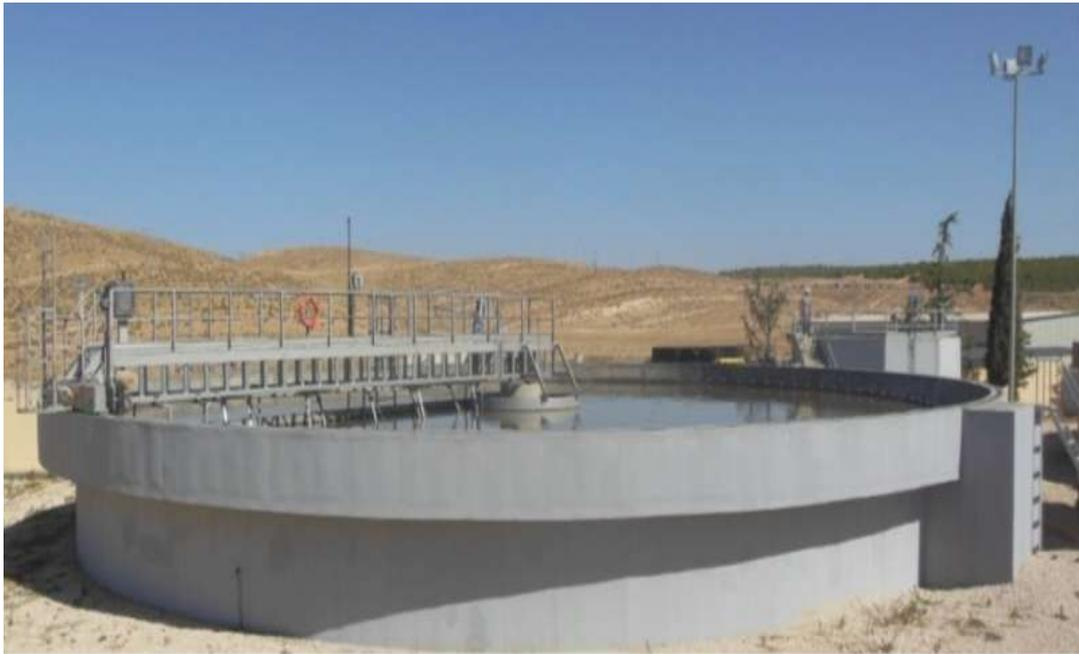
**Figure III.12 :** Décanteur primaire (nouvelle file)
