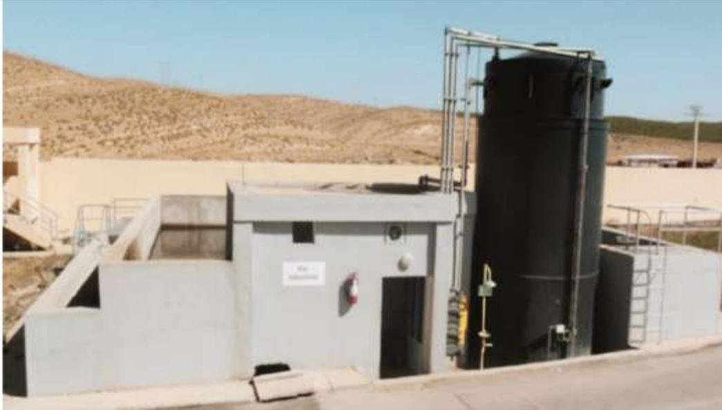
**Figure III.15 :** Station de chloration nouvelle file
