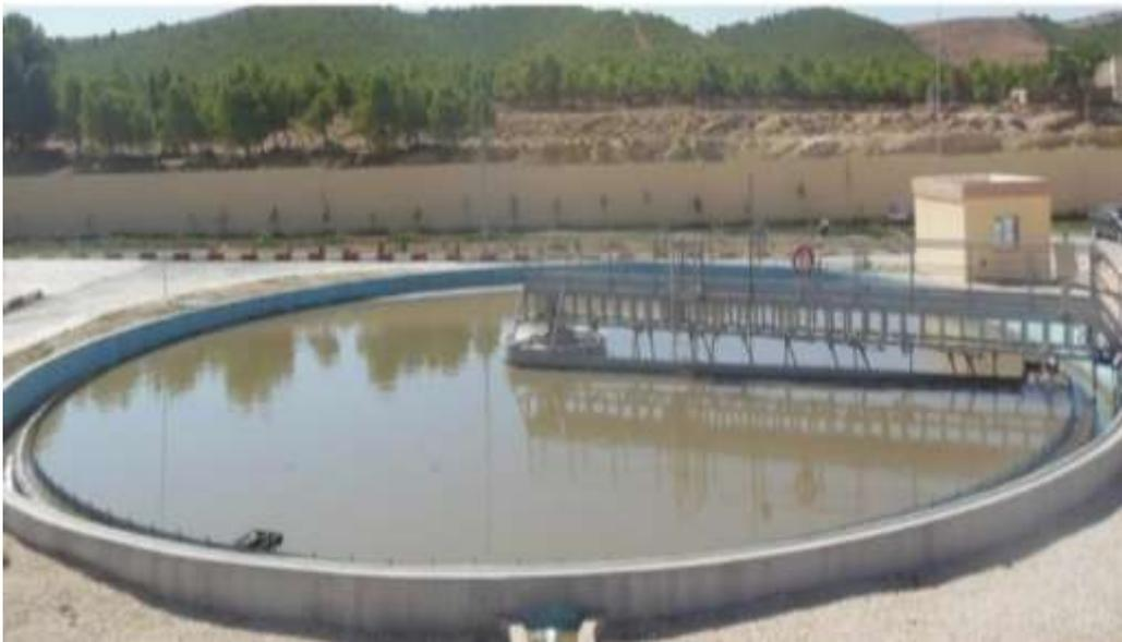
**Figure III.8 :** Décanteur primaire file existant
