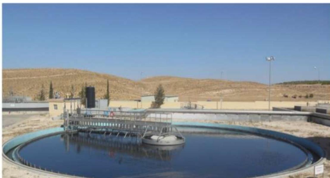
**Figure III.10 :** Décanteur secondaire (clarificateur) file existante
