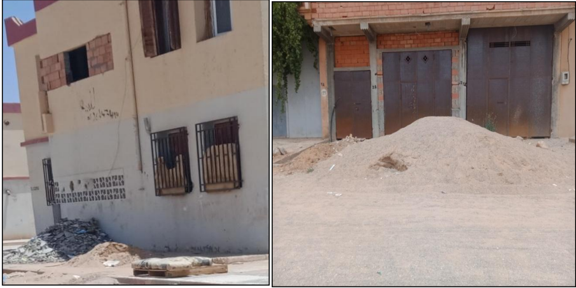
الصورة رقم (21): وضع مواد البناء على الطريق العمومي
