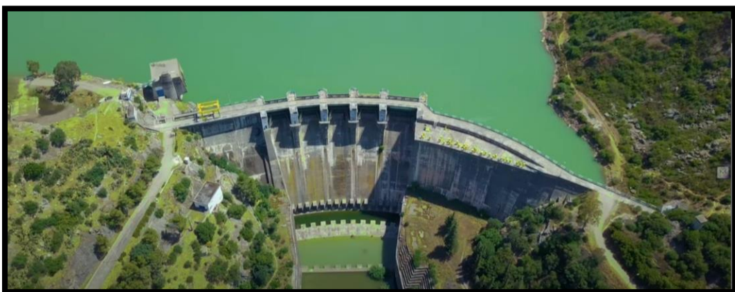
Figure 9 : la digue du barrage de Zardezas (google Earth- juillet 2023)
