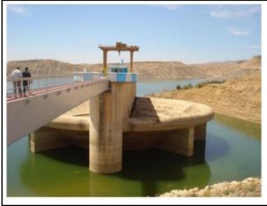
Figure 21 : Couleur verdâtre de l'eau du barrage de SMBA.
