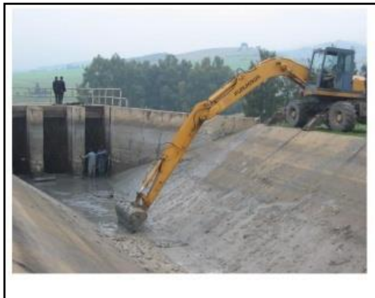
Figure 20 : Curage d'un canal par les moyens mécaniques (OPIM, 2008).
