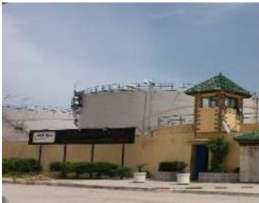
Photo :06 : Façade nord de l'usine
