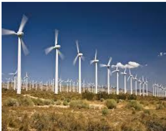
Photos 20 : champ d'éoliennes Source : Britannica
