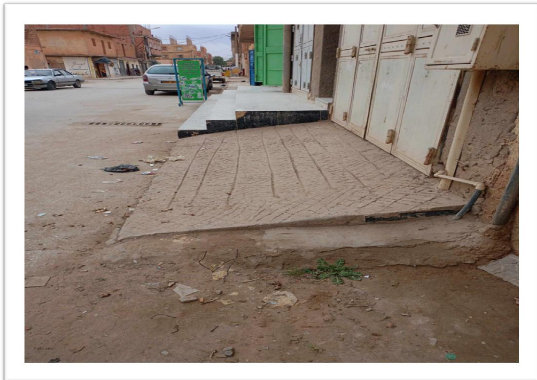
صورة 3: حالة الرصيف المتدهورة (التقاط الطالبة، جانفي 2024)
