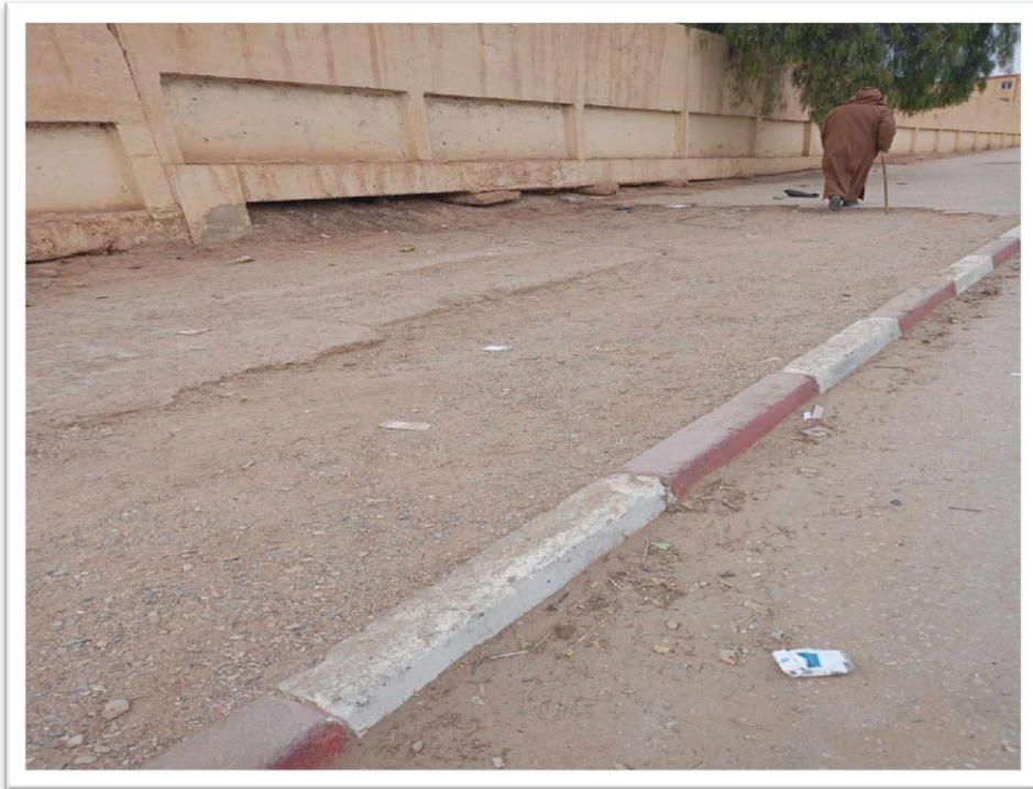
صورة 1: حالة الرصيف المتدهورة (التقاط الطالبة، جانفي 2024)
