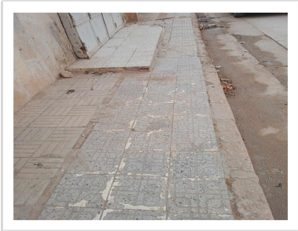
صورة 2: حالة الرصيف المتدهورة (التقاط الطالبة، جانفي 2024)
