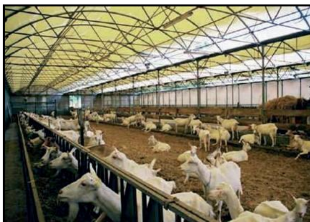
Figure 07: Un Bâtiment type tunnel ( PRADAL, 2014 ).
