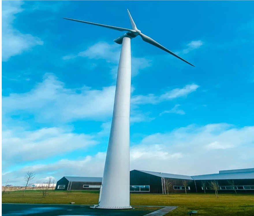
Figure.II. 10. Éolienne de 100 kW de grand vent.
