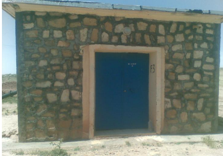
Photo 1 : Vue extérieure du forage
