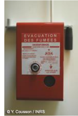
Figure 31. Système d'évacuation de fumés
