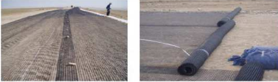
Figure1.22.b. Utilisation du géogrid dans le renforcement.
