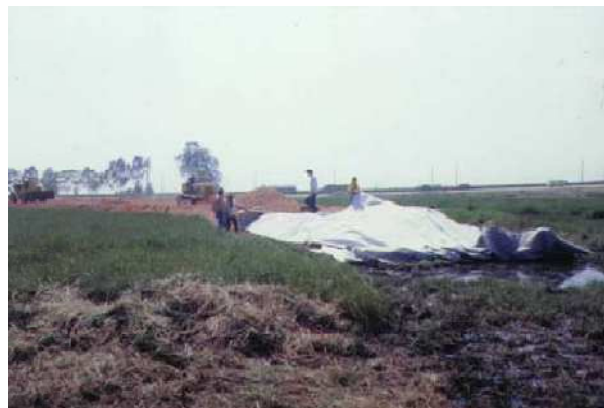
Figure1.29. Construction d'une route non revêtue sur une argile organique molle.
