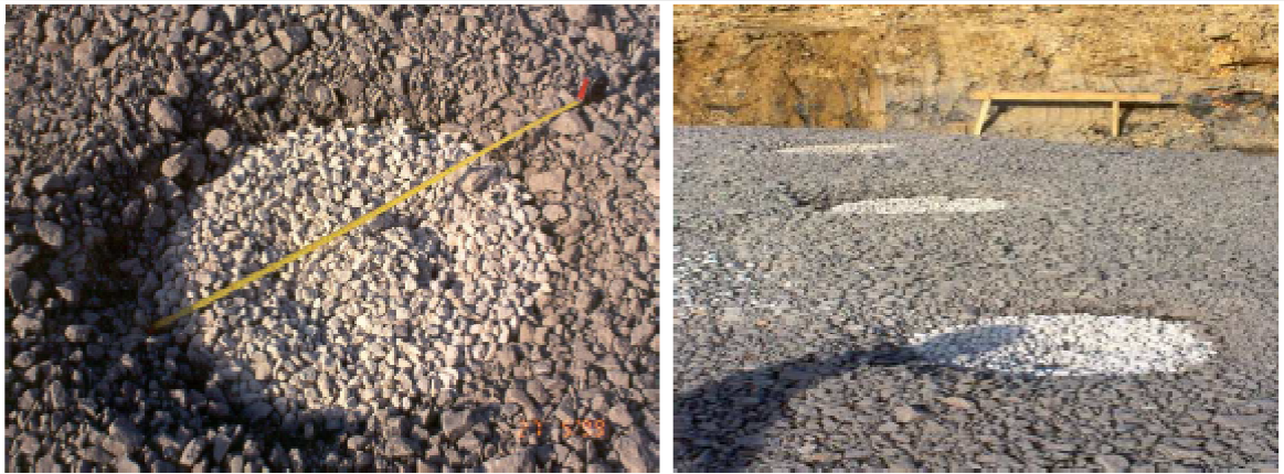
Figure 1. 37. Mise en œuvre des colonnes ballastées par voie sèche (Document de Keller®).
