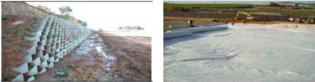
Figure 1.15. Pose des géotextiles de renforcement.
