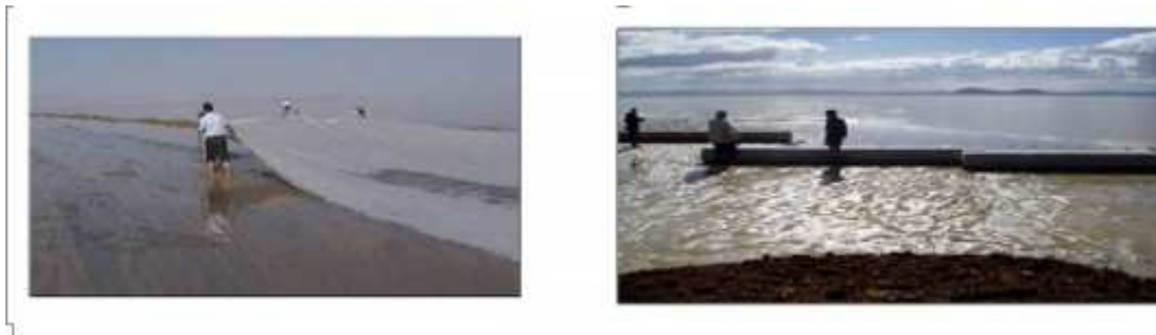
Figure 1.13. Pose des géogrilles de séparation.
