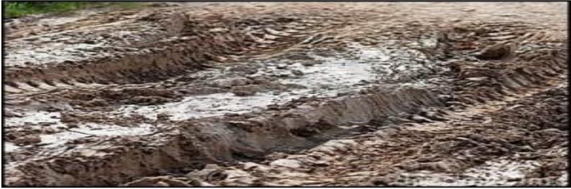
**Figure I.7:** traitement d'un sol en place à la chaux.
