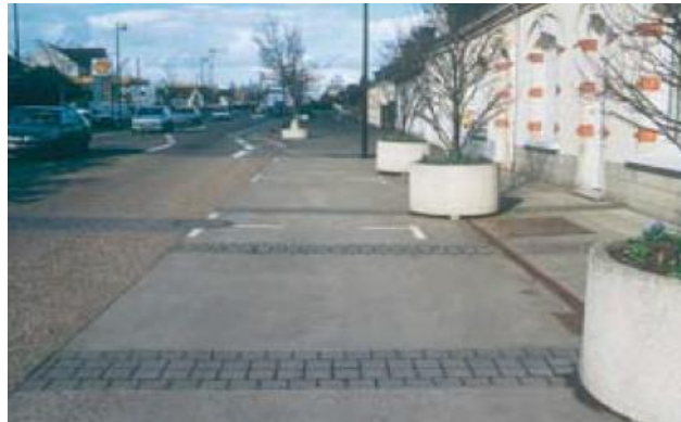
(k) Aménagements urbains- avenue nationale d'Arnage-France
