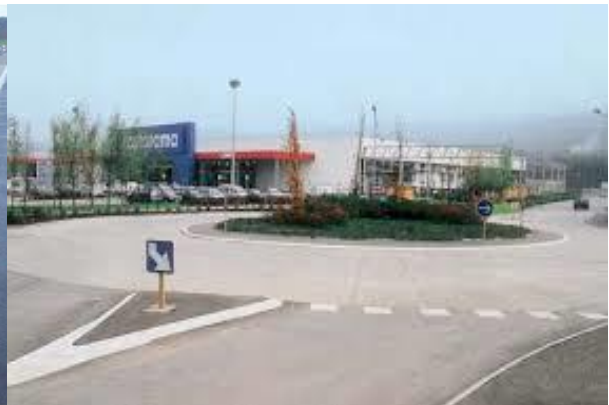
(b) Carrefours giratoires des Landiers à Chambéry-France
