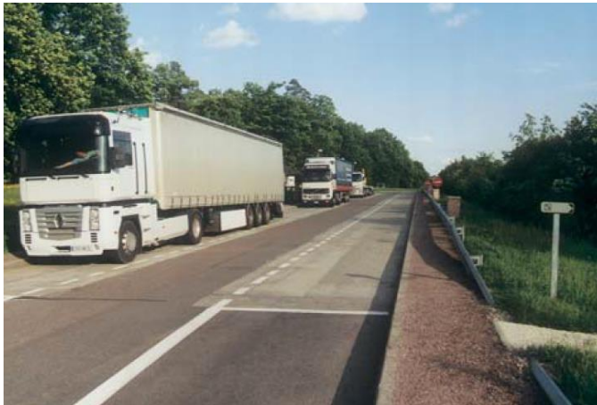
(e) Aires de parking poids lourds de l'autoroute Thureau-France
