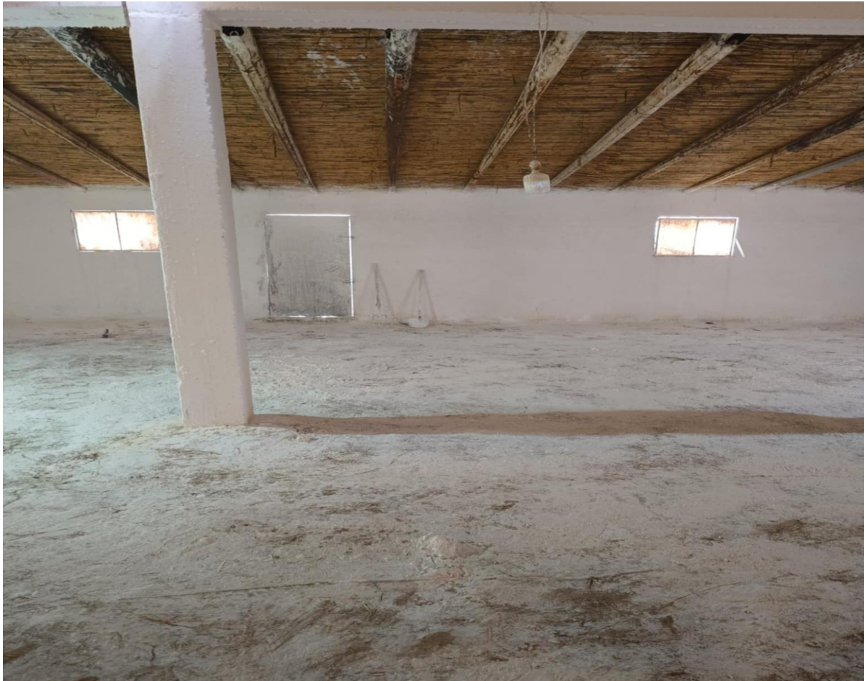
Figure 13 : Désinfection du sol, des murs et application de la chaux
