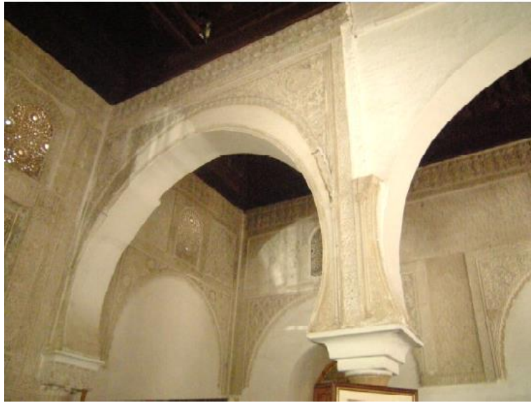
صورة 32: أحد عقود البلاطة الوسطى والجدار الجنوبي
