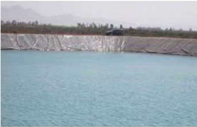
Figure1. 20 : géosynthétique en barrage
