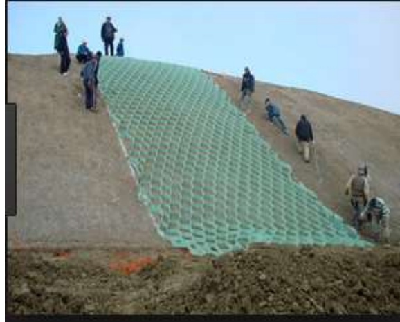
Figure1. 27 : géogrilles pour stabilité le sol
