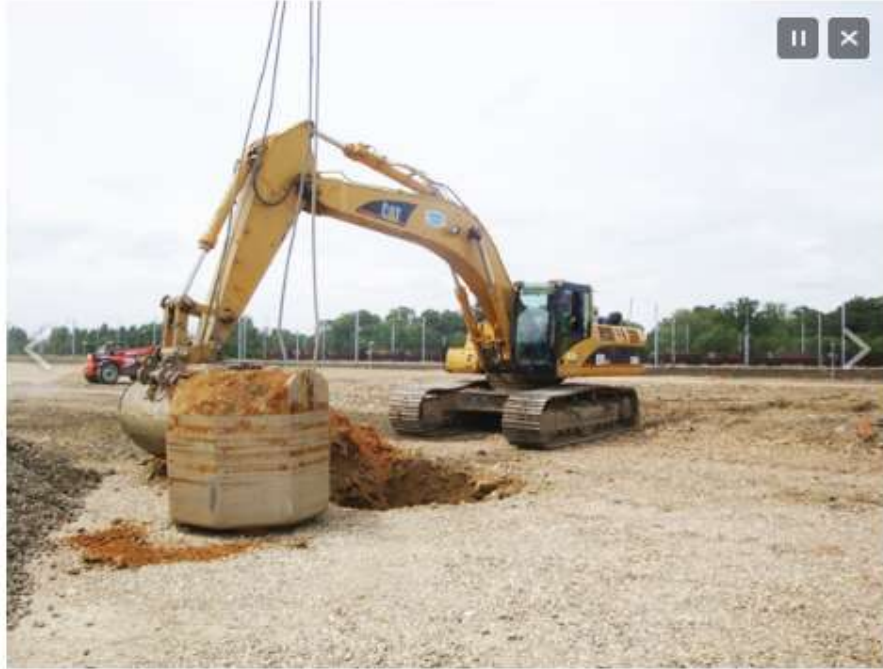
Figure 1.6 : plots ballastés : pré-excavation
