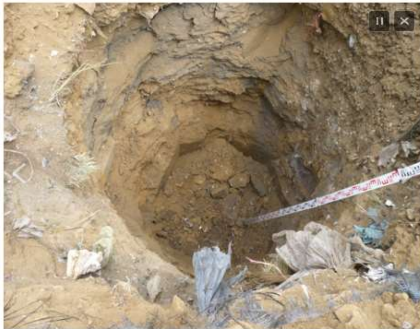
Figure 1.5 : Empreinte dans une ancienne décharge – Réalisée par chute libre répétée de la masse sur un bouchon de matériaux d'apport
