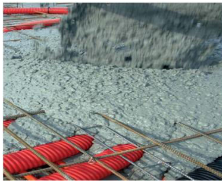
Photo 1.1 : Coulage de BAP dans une dalle très encombrée [HOLCIM,2004]
