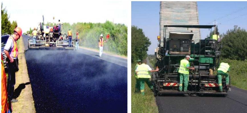
**Fig.2.15.** *Technique de l'asphalt caoutchouté*
