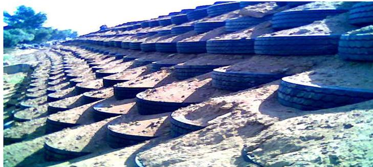
**Fig. 2.4.***Pose des nappes de pneus Projet pilote – Route de Bousmail*
