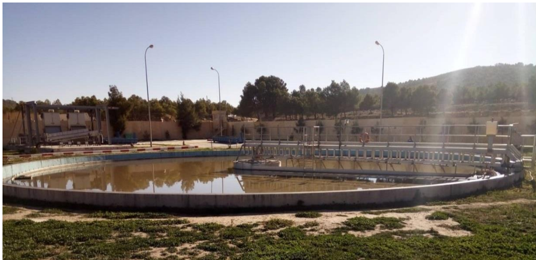
Figure III.9 : Décanteur primaire file existant
