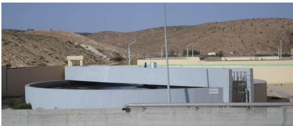
Figure III.17 : Epaisseur des boues
