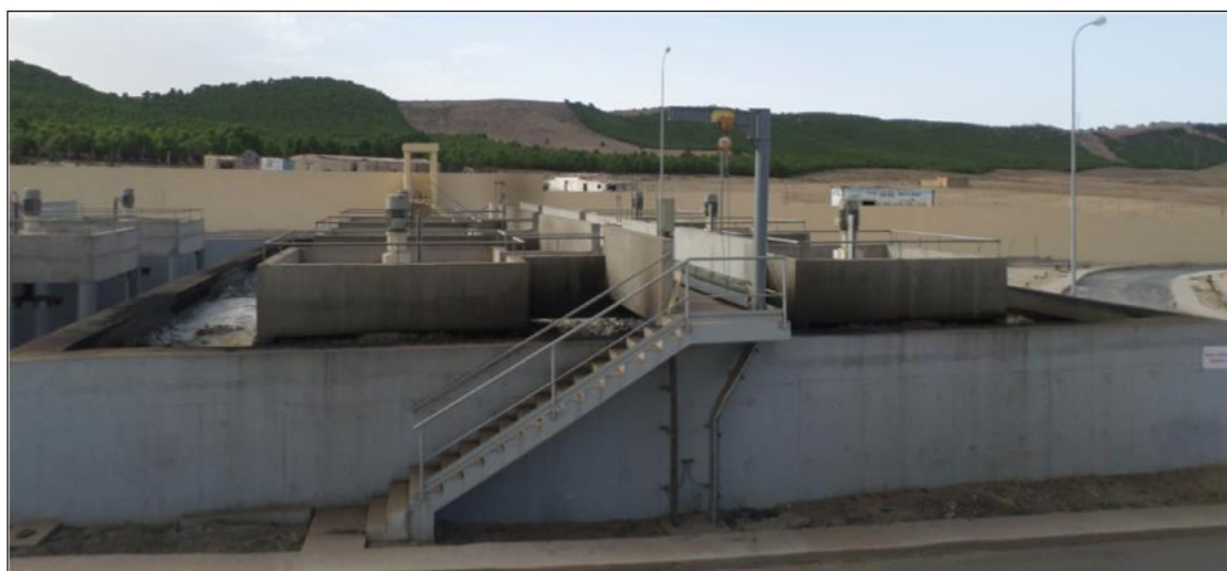
Figure III.14 : Bassin d'aération nouvelle file
