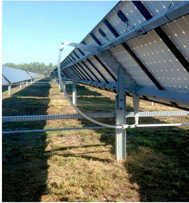
Figure 1.5 : Trackers (suiveurs) à double axe
