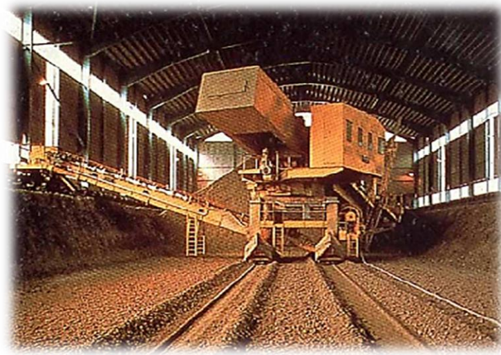
Figure 6 : Hall de pré-homogénéisation de la cimenterie de Hamma Bouziane
