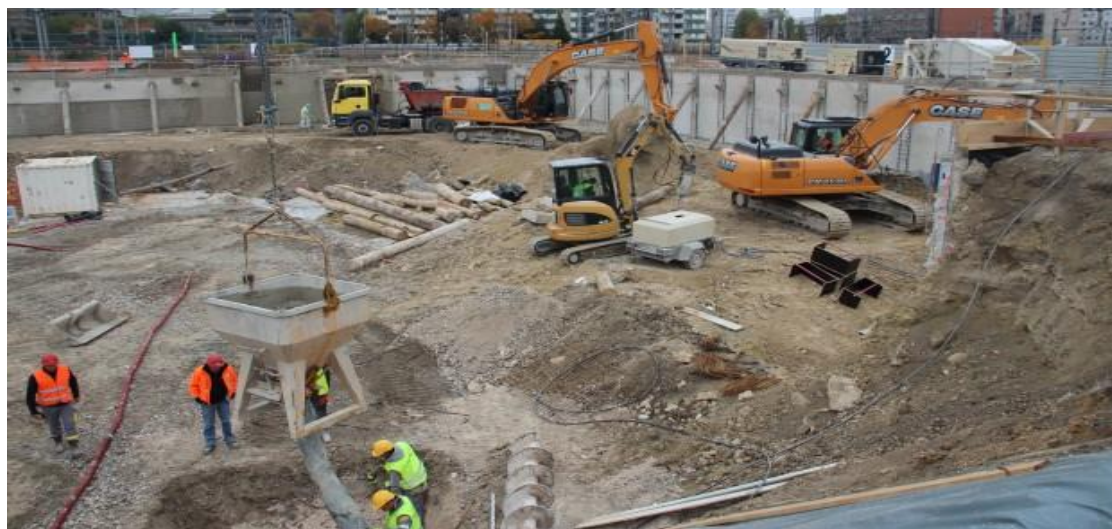
Figure N°03: La dépollution sur le site après avoir excavé les terres (Rebhi, 2019).
