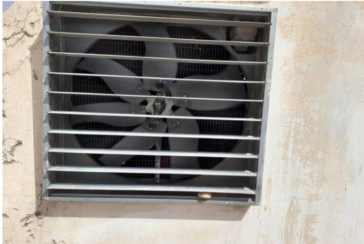
Fig.31- Ventilation dynamique (Extracteur) dans l'élevage de Dar Chioukh (Originale).
