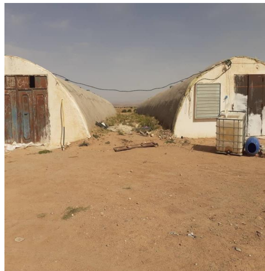
Fig.27- Vue extérieure des bâtiments
