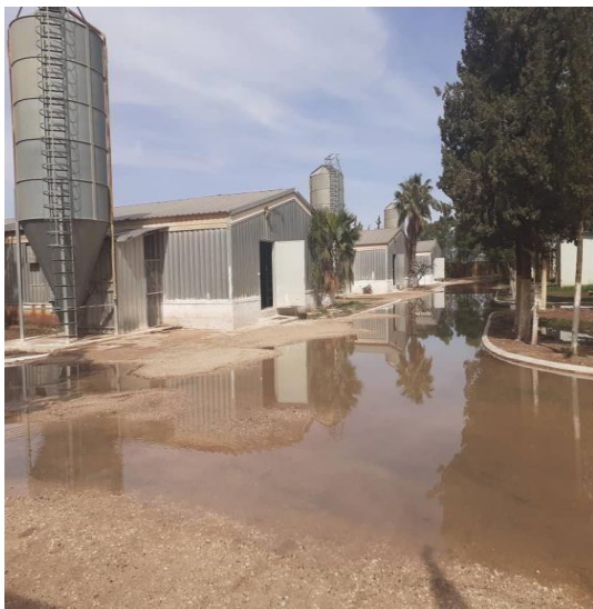
Fig.26- Vue extérieure des bâtiments
