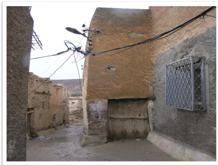
Figure 16, Une photo montrant l'installation des fils électriques, La source : prise par l'étudiant 23-05-2021
