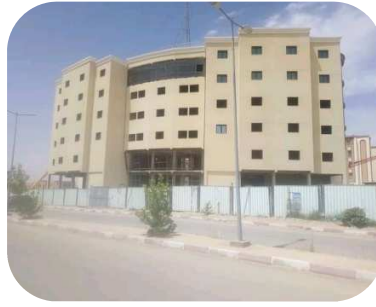
Equipement en cours
