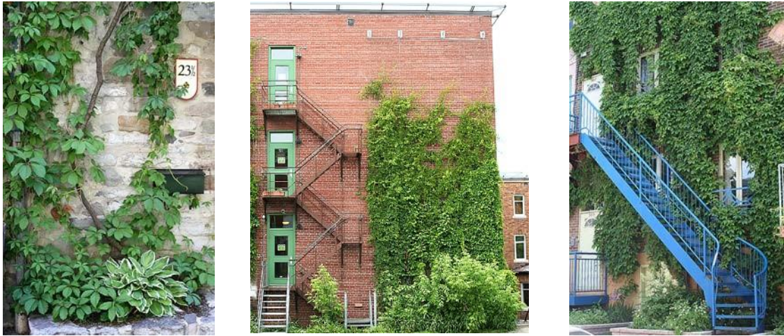
Figure N°47: Murs végétaux de façade
