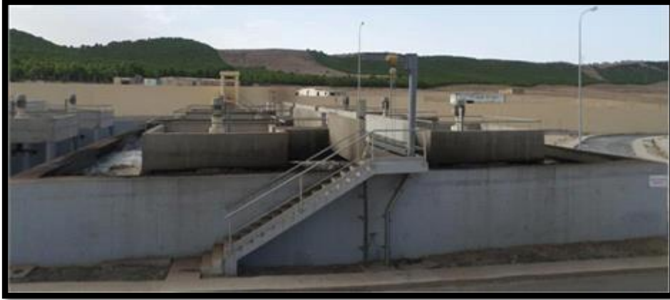
Figure 16 : Bassin d'aération nouvelle file (Juillet 2021)
