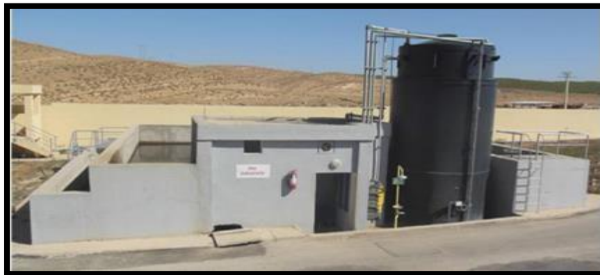
Figure 18 : Station de chloration nouvelle file (Juillet 2021)
