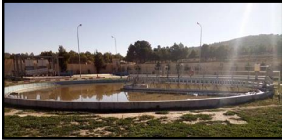
Figure 11 : Décanteur primaire file existant (Juillet 2021)
