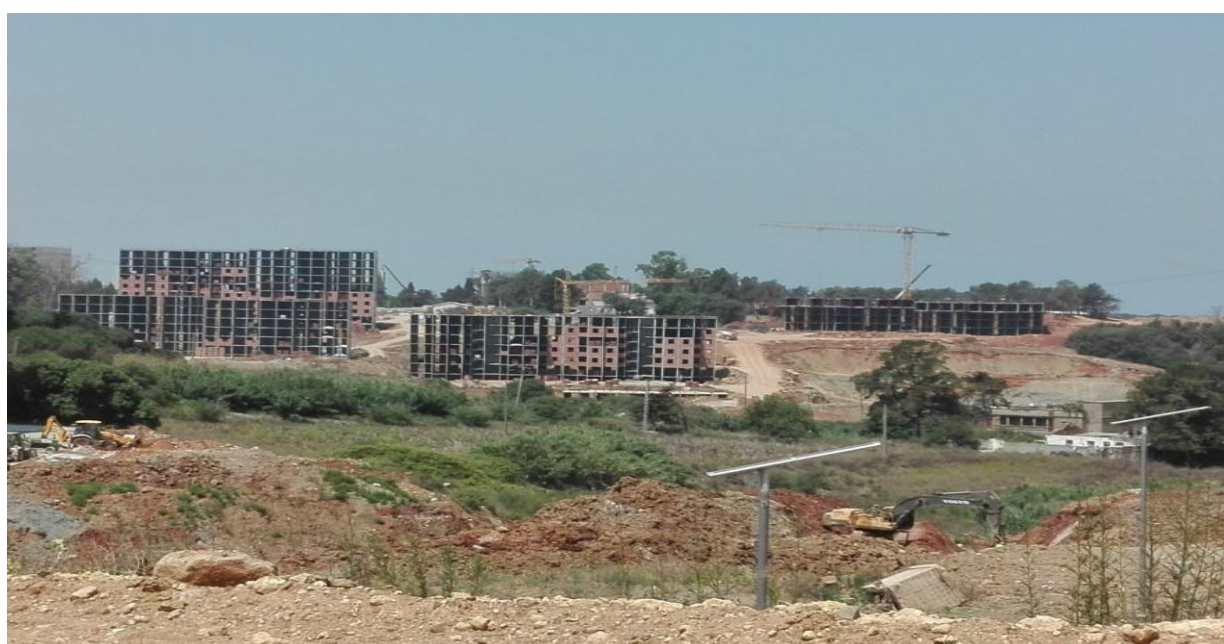
Photo n 01:Décapage des terres en cours, état d'avancement 01 % (CEM )
