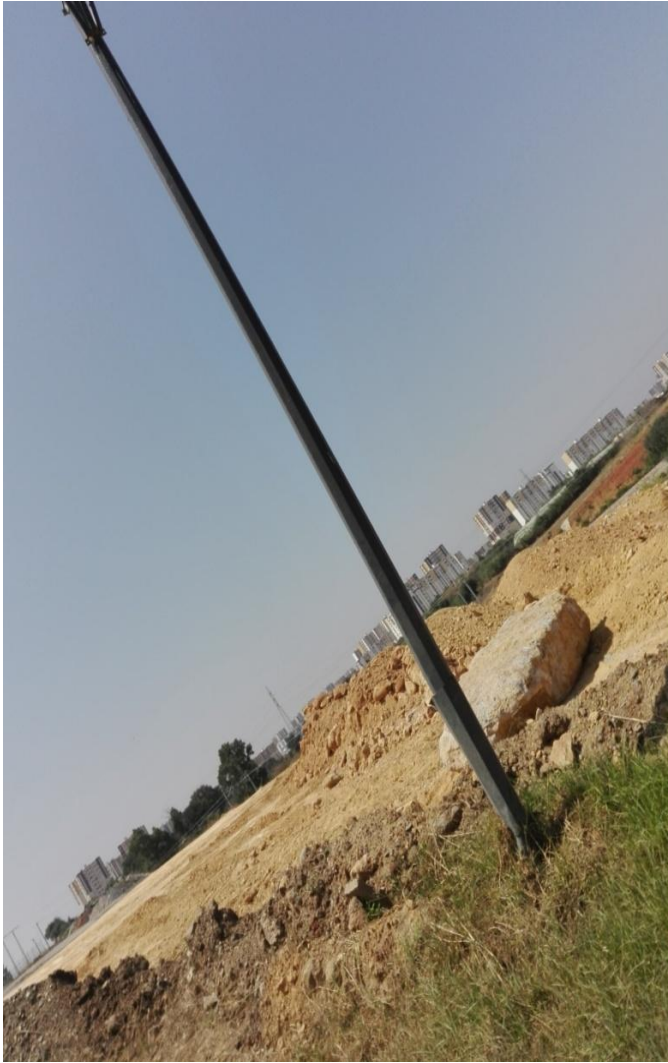
Photo n 02 : Décapage des terres en cours (jardin D'essai)
