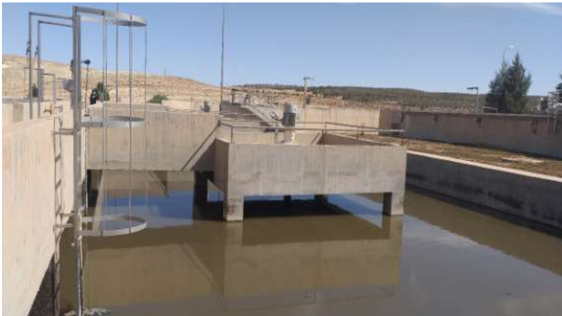
Figure IV.9 : Bassin d'aération file existant
