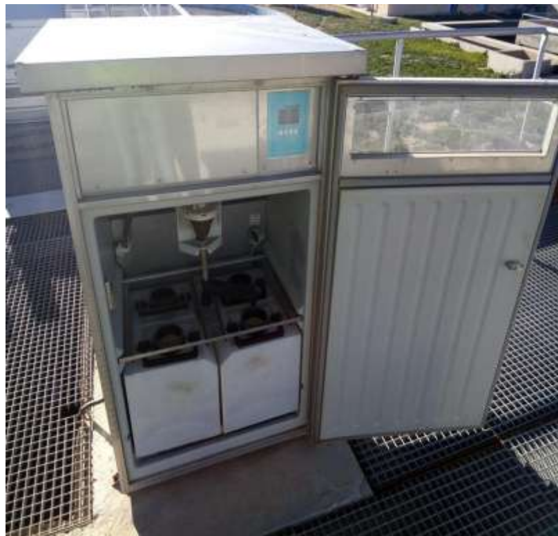
Figure IV.5 : Préleveur d'échantillons automatique
