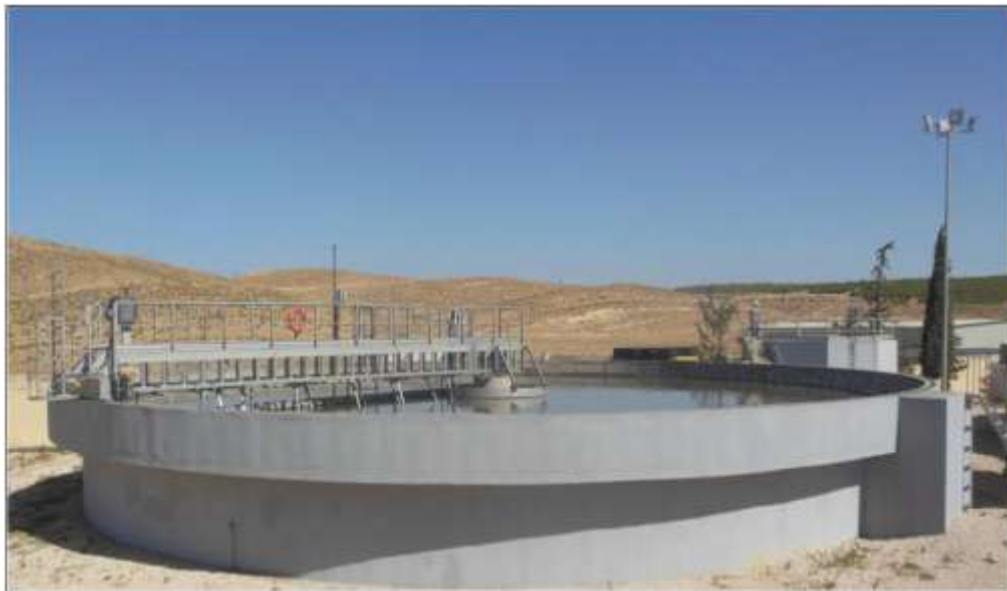
Figure IV.12 : Décanteur primaire nouvelle file
